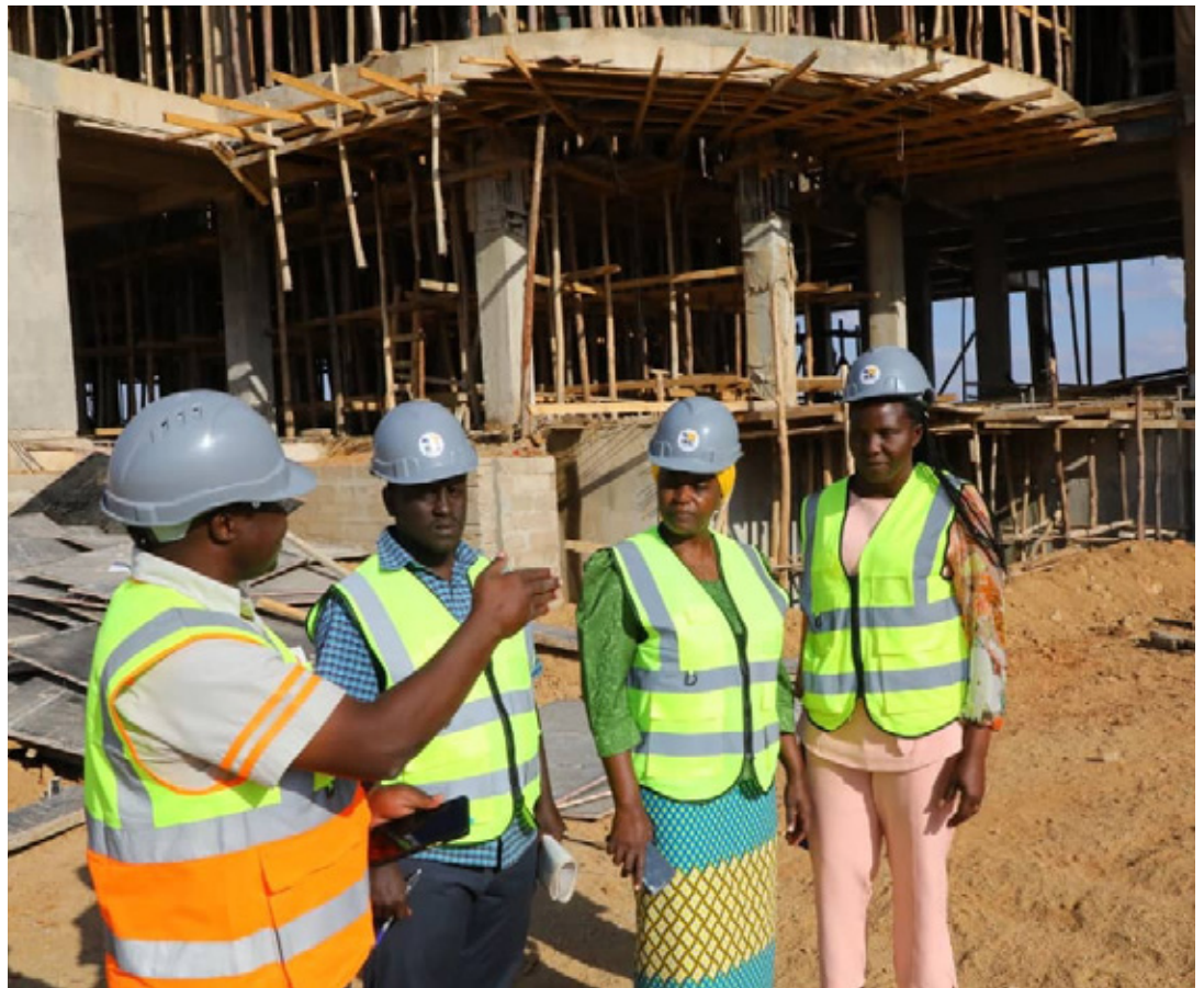
Mkurugenzi wa Utawala na Rasilimali watu kutoka Wizara ya Nishati Bi. Ziana Mlawa (wa pili kulia) akikagua maendeleo ya ujenzi wa jengo la ofisi za Wizara ya Nishati, linalojengwa katika Mji wa Serikali Mtumba, jijini Dodoma, Agosti 2022.
