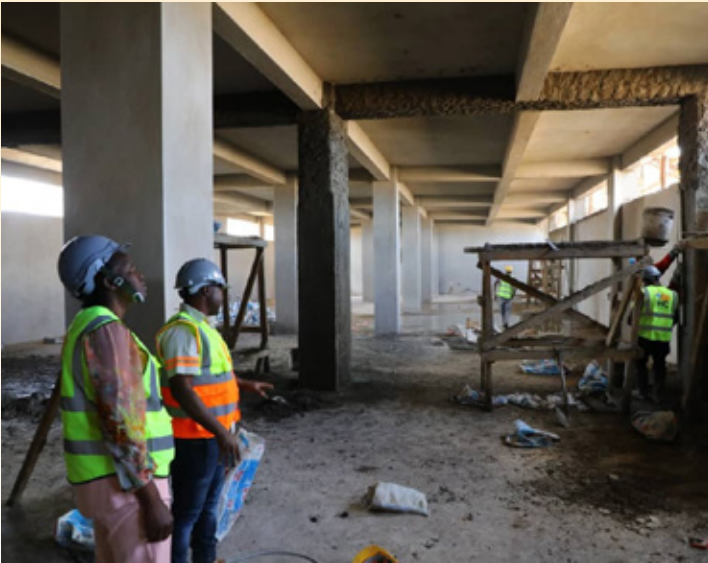
Mkuu wa kitengo cha Mawasiliano Serikalini, Bi. Dorina G. Makaya (wa kwanza kushoto), akikagua na kutazama maendeleo ya Ujenzi wa jengo la ofisi za Wizara ya Nishati, Agosti 12, 2022.
